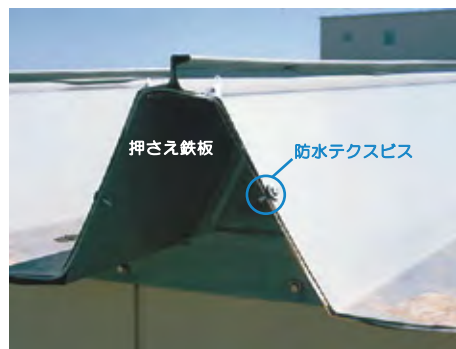
下付け方式施工状況例
