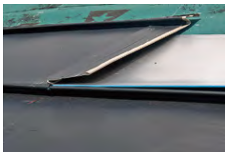
屋根材の裏に敷設する
