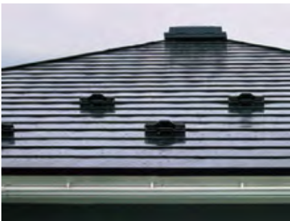
横葺き屋根の例
